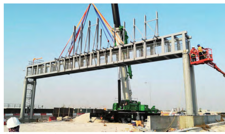
在卡塔尔现场安装钢结构
